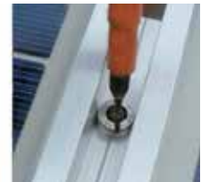
Öffnen (z.B. bei Moduldefekt): Schlitz einschneiden und mit großem Schraubendreher lösen.
