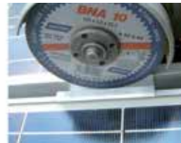
Öffnen (z.B. bei Moduldefekt): Schlitz einschneiden und mit großem Schraubendreher lösen.
